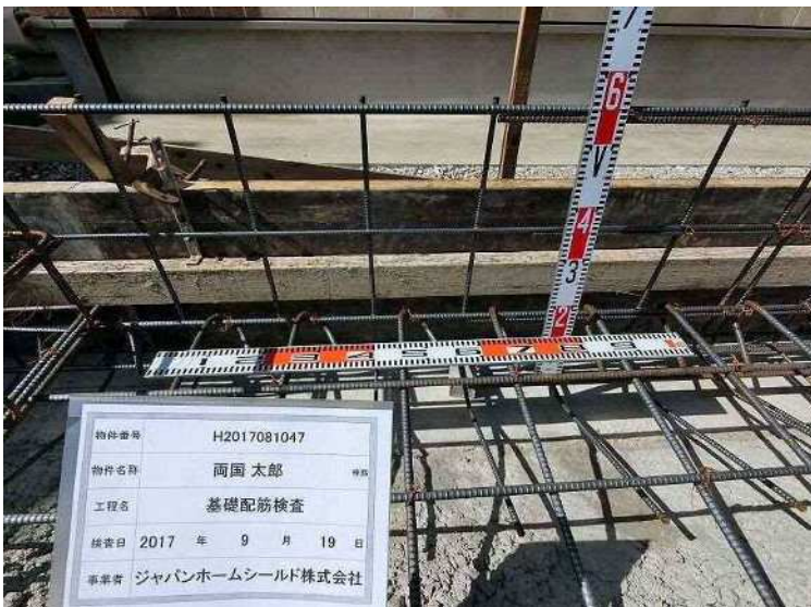
基礎立上がり
