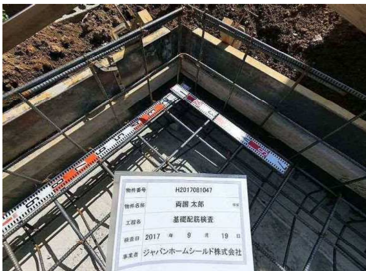
継手補強（コーナー部）
